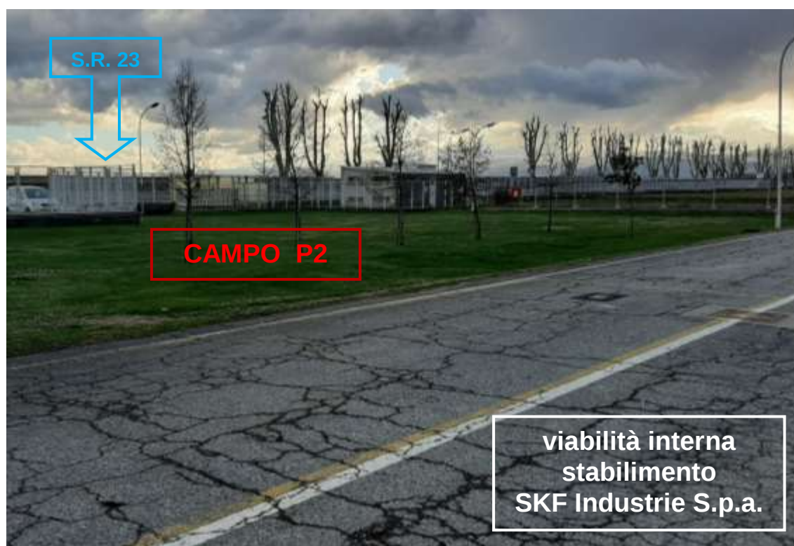
Vista del Campo P2 – zona est
