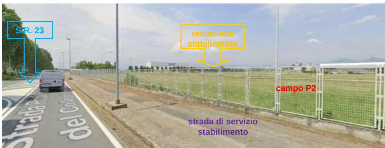
Vista del Campo P2 dalla viabilità S.R. 23 del Sestriere – zona ovest
