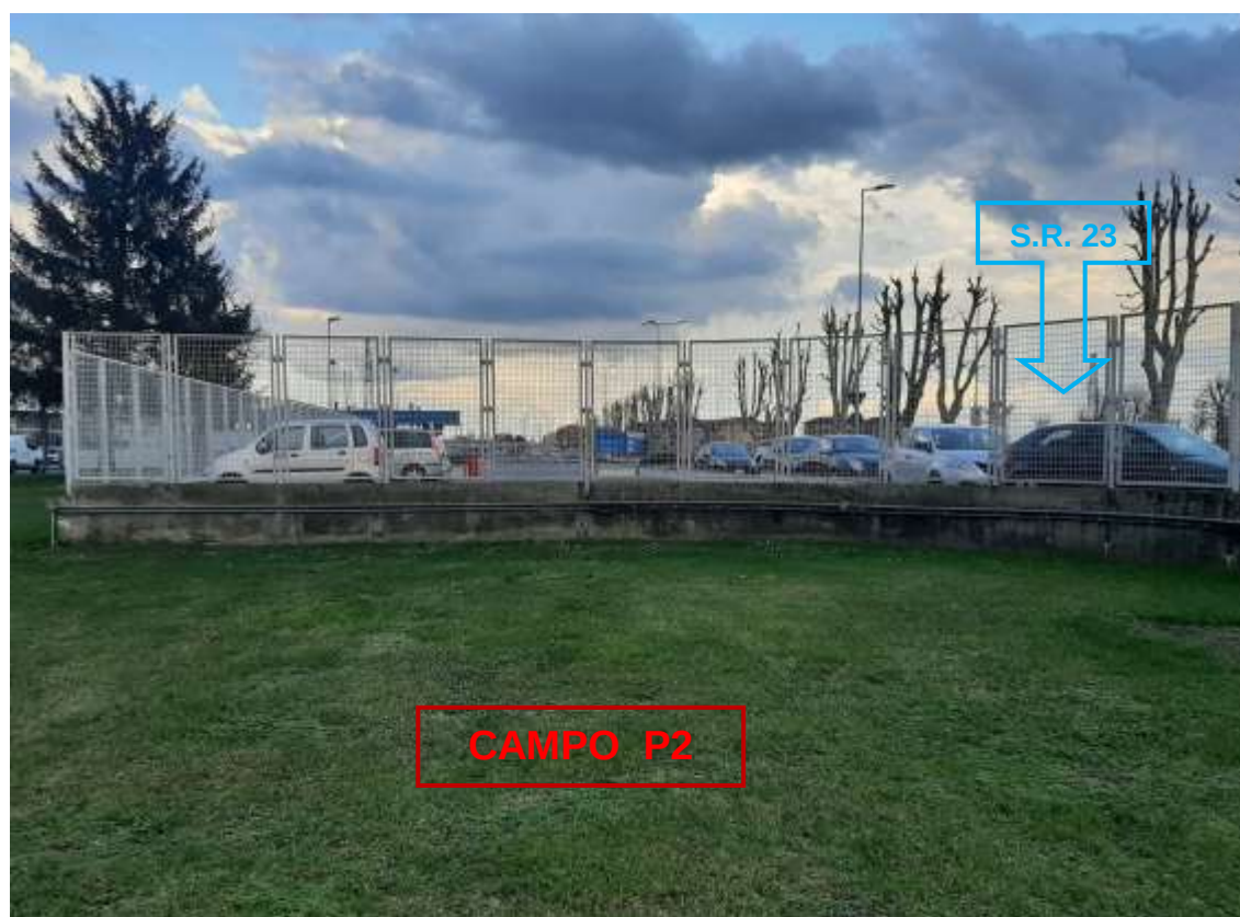
Vista del Campo P2 – Muro di recinzione in cui sarà realizzato il nuovo accesso carraio
