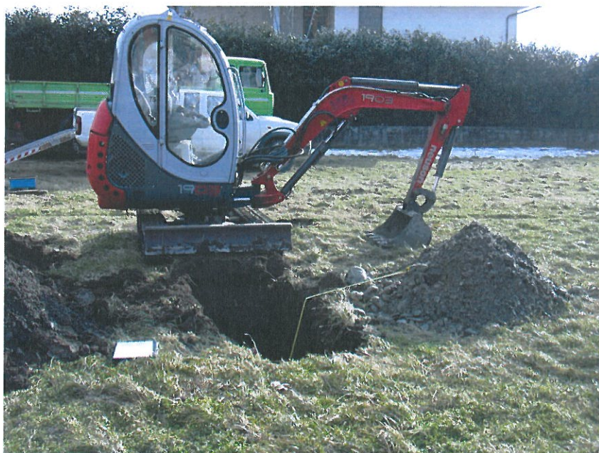
Escavatore Neuson 1903 utilizzato per la realizzazione dei pozzetti geognostici
