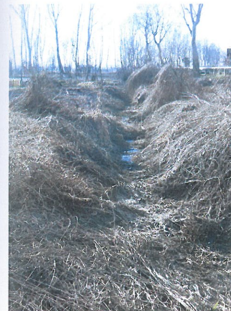
Rio Filonetto in corrispondenza dell'area di intervento: si noti il carattere infestante ed ostruente della vegetazione.
